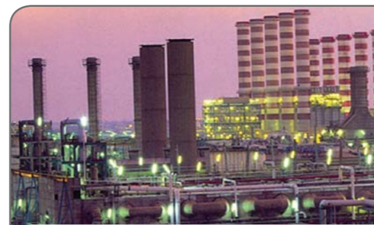
Lng / Usines Chimiques
